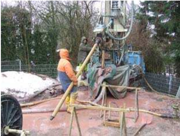
Am Freitagmittag setzten die Arbeiter bereits das letzte Teil des Bohrgestänges für die erste 100 Meter tiefe Bohrung ein. (Foto: ww)
